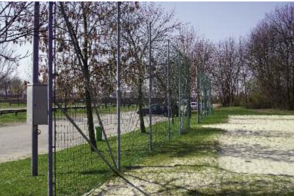
Ballfangzäune, in der richtigen Höhe und im richtigen Abstand situiert, sind ein wichtiger Bestandteil des Sportplatzes
