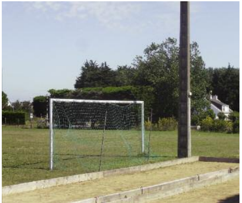
Dieser Flutlichtmast benötigt, insbesondere bei zu geringem Abstand zum Spielfeld, eine zweckmäßige Absicherung!
